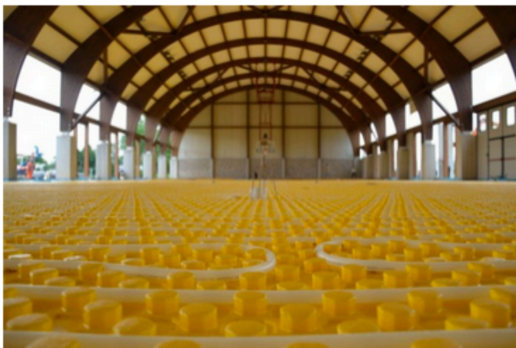
Con Planibeton realizzare il massetto autolivellante ha richiesto tempi più rapidi, con una presa di soli due giorni (foto di Betonrossi)
