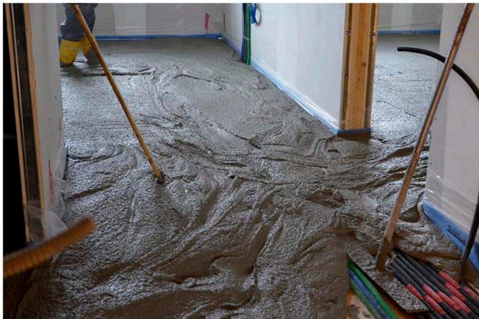
Neoisolbeton, questo il nome del nuovo formulato, è un conglomerato con massa volumica da 4 a 8 volte minore rispetto a quella di una tradizionale malta per massetti cementizi e una conducibilità termica di 0,068 W/mk.
