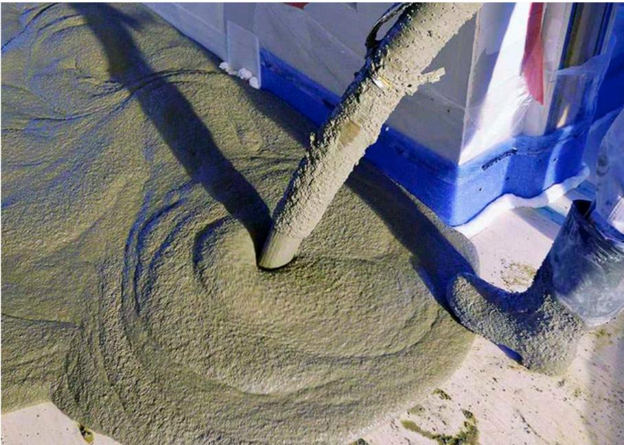
Le perle di **Basf**, caratterizzate dal colore grigio sono state scelte da **Betonrossi** per la realizzazione di una nuova malta alleggerita, termoisolante particolarmente adatta per riempimenti e sottofondi di solai e tetti piani come strato di supporto ai massetti per la posa di pavimenti.
