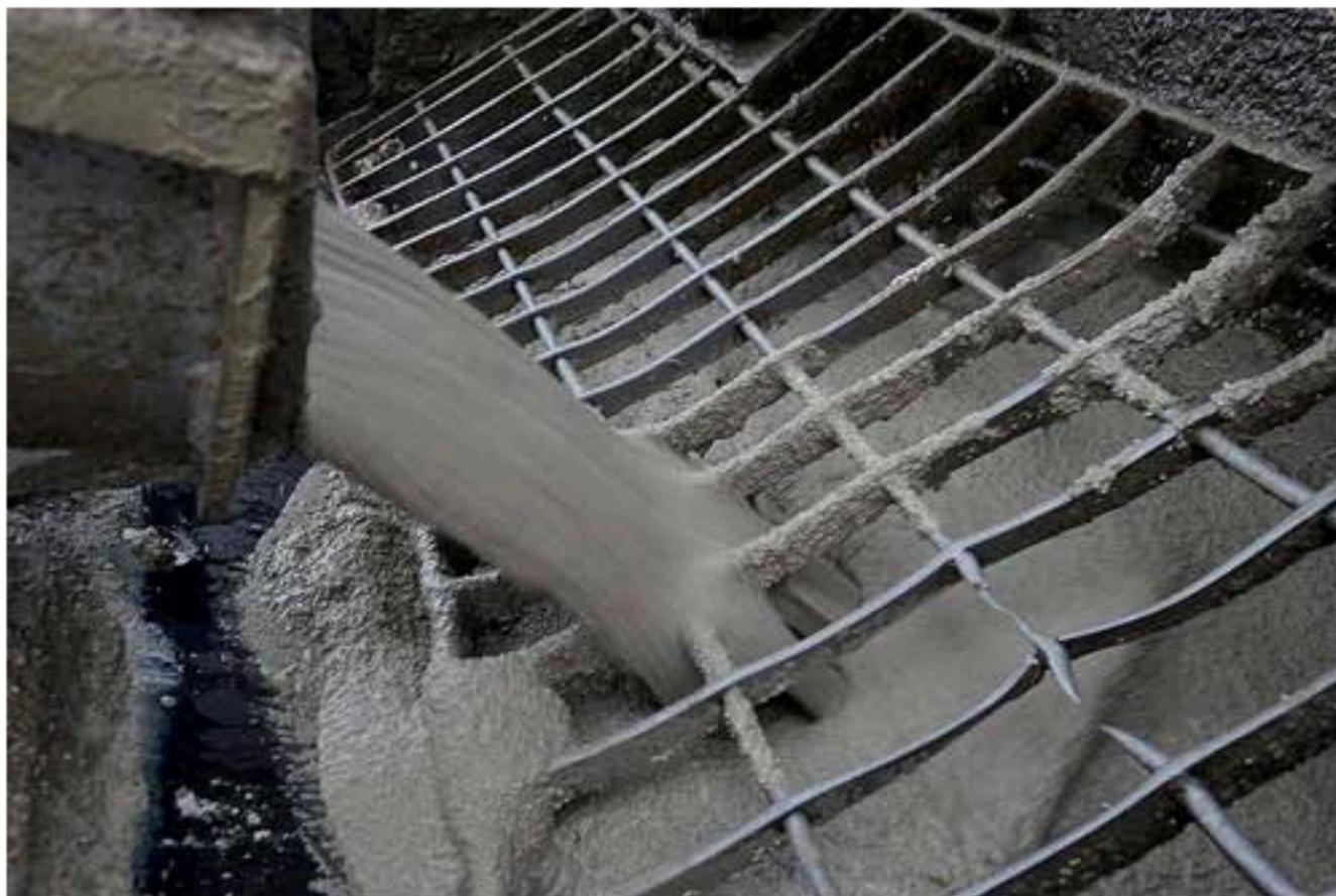
Infine, va sottolineato che le caratteristiche intrinseche di Neoisolbeton™ sono state migliorate grazie all'esperienza di Consorzio Novaedil che ha inserito nella miscela un accelerante che ha reso possibile l'asciugatura in tempi record, in giornate notevolmente umide, in cui la percentuale di umidità in cantiere ha raggiunto quasi il 100%, dando la possibilità di anticipare i getti dei massetti rispetto ai tempi previsti.
