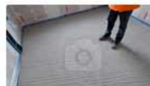
Per migliorare ulteriormente la **resistenza termica** dell'intero pacchetto-solaio, si potrà realizzare il massetto con **Termobeton 1400**, calcestruzzo alleggerito con argilla espansa.
