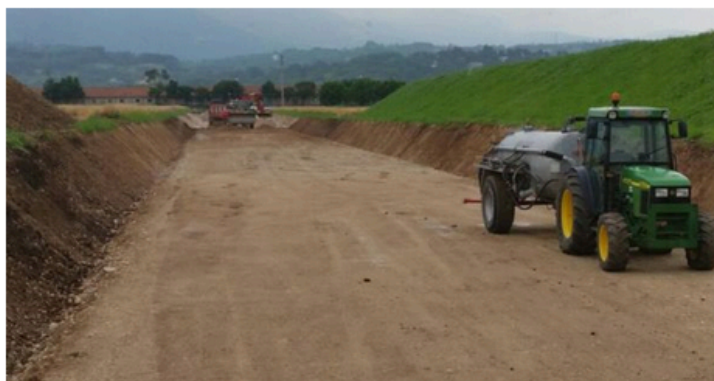
Il calcestruzzo drenante di Betonrossi è stato utilizzato per risolvere un problema di cedimento stradale nella cava di Bai rendendola percorribile con mezzi pesanti.
