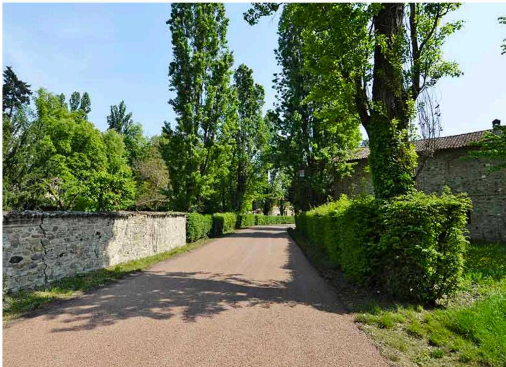
L'intervento, effettuato da Betonrossi, ha previsto la riqualificazione della pavimentazione stradale di Strada della Cà Matta, attraverso la rimozione del conglomerato bituminoso presente, che si stava degradando a causa dell'elevato stress subito, la sistemazione e regolarizzazione del sottofondo e il successivo impiego del calcestruzzo drenante *DrainBeton*.
