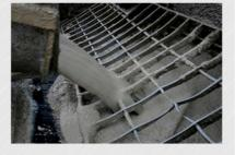
acusticamente assorbente, confezionata con Neopor® di BASF, aggregato leggero di polistirene espanso additivato con grafite, ideale per la realizzazione di riempimenti e sottofondi necessari per la successiva realizzazione dei massetti destinati alla posa di pavimenti in materiale ceramico, lapideo o in legno.
